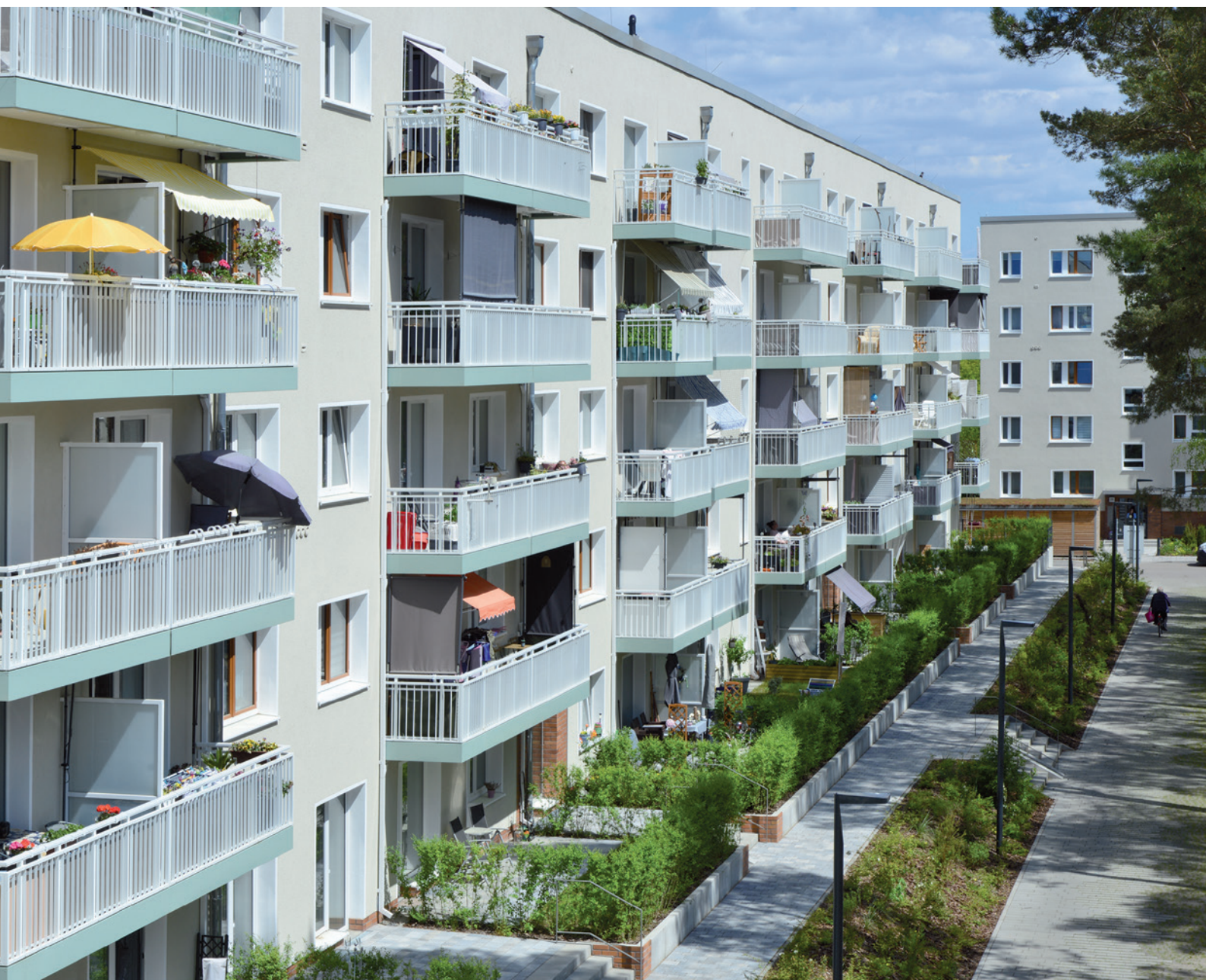
Modernisierte Fassade mit Balkonen und Mietergärten © Olli Hein
