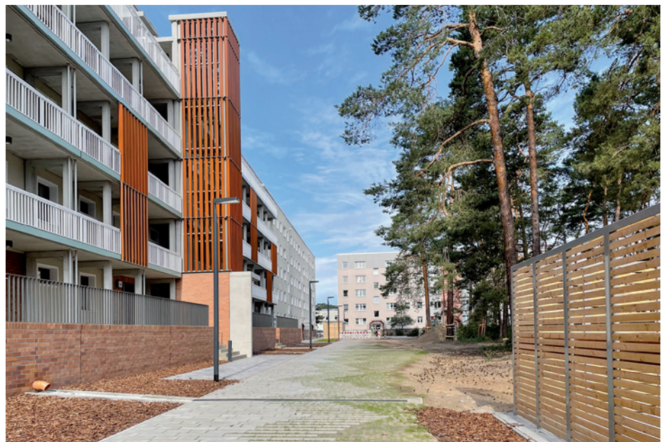
Laubengänge und Außengestaltung © Kerstin Köhler, Wohnungsgenossenschaft Eberswalde 1893 eG
