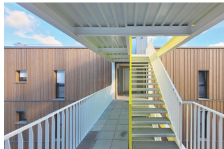
Stegverbindung Bauteil 3 © FFM-Architekten. Arno Rothacker
