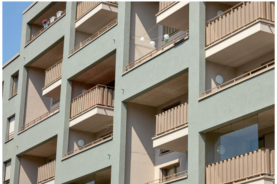
Blick auf die zweigeschossigen Maisonette-Balkone © Michael Reisch
