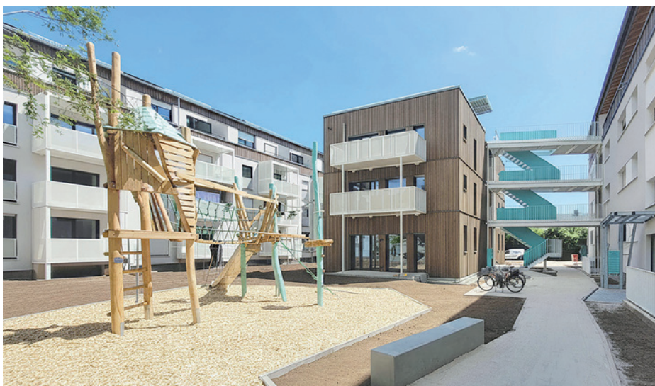
Blick auf Bauteil 1, straßenseitig © FFM-Architekten. Arno Rothacker
