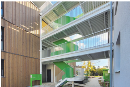
Stegverbindung Bauteil 4 © FFM-Architekten. Arno Rothacker
