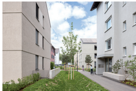
Versickerungsfläche und Quartiersweg zwischen Bestand und Neubau © Börje Müller
