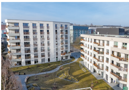
Freiberger Garten mit Blick zum Punkthaus © Wohnungsgenossenschaft Freiberg eG
